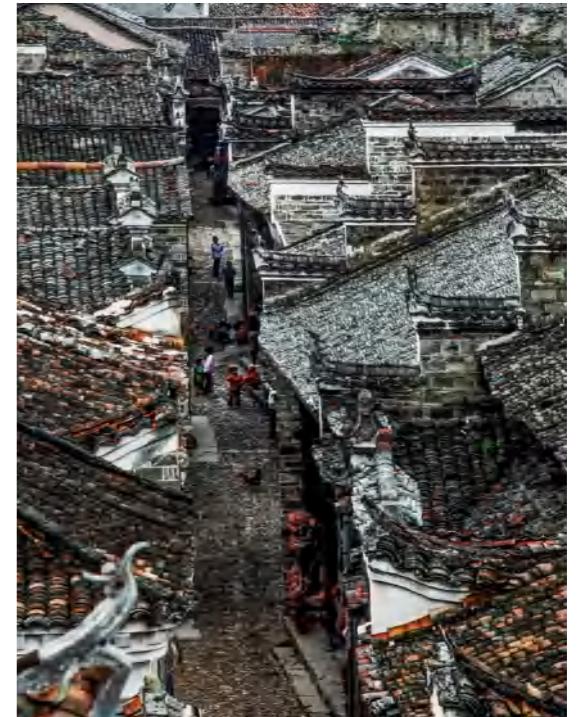
流坑古村建筑 明代 江西乐安
